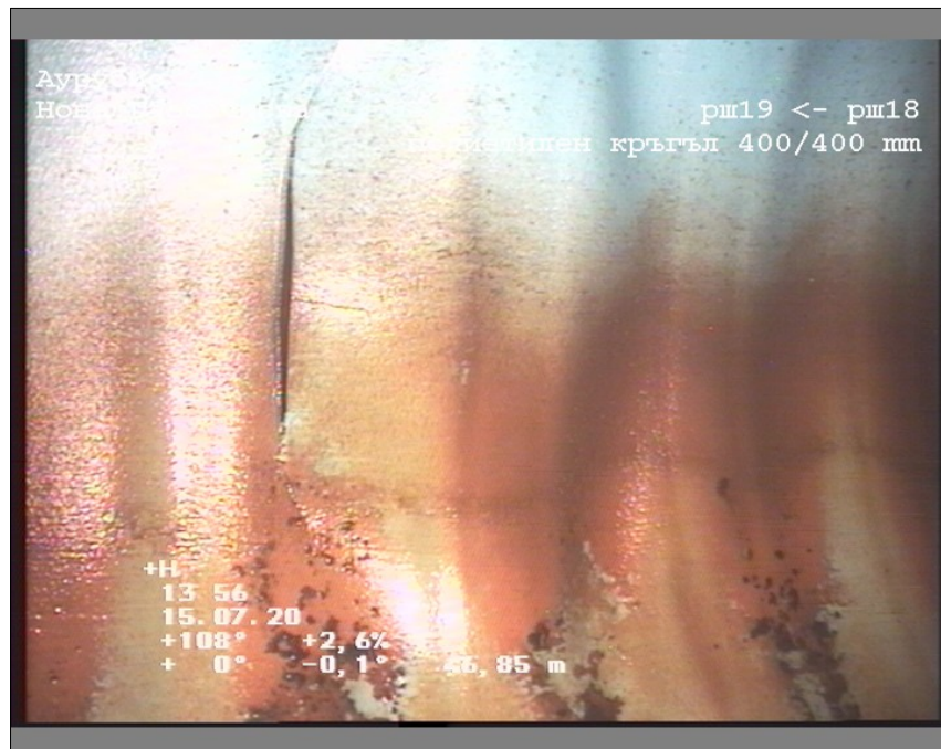
Снимка: 7_13А, Носител данни №: 15.7.2020 г._0, 00:12:26 46,85m, Пукнатини около тръбата, 3mm широк, от 3 до 4 Часа
