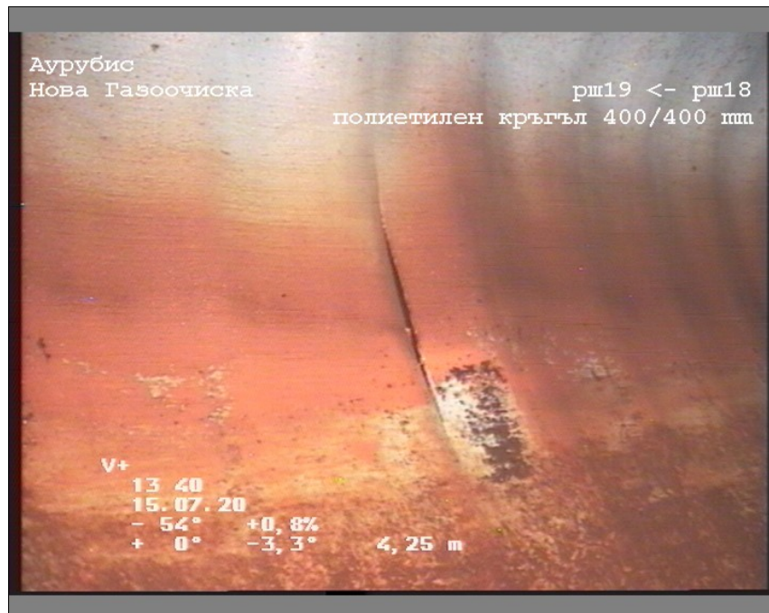
Снимка: 7_2А, Носител данни №: 15.7.2020 г._0, 00:01:10 4,25m, Пукнатини около тръбата, 3mm широк, от 8 до 9 Часа
