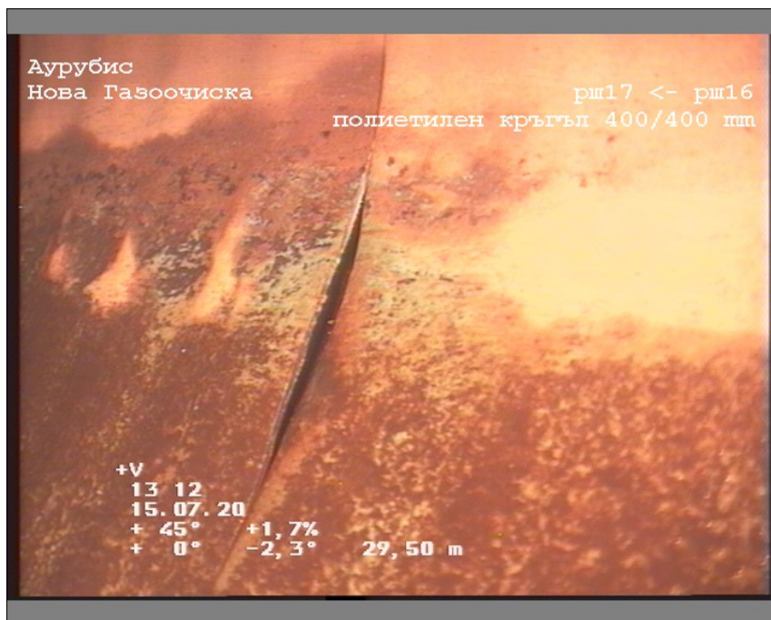
Снимка: 6_4А, Носител данни №: 15.7.2020 г._0, 00:05:25 29,5m, Пукнатини около тръбата, 10mm широк, от 4 до 5 Часа
