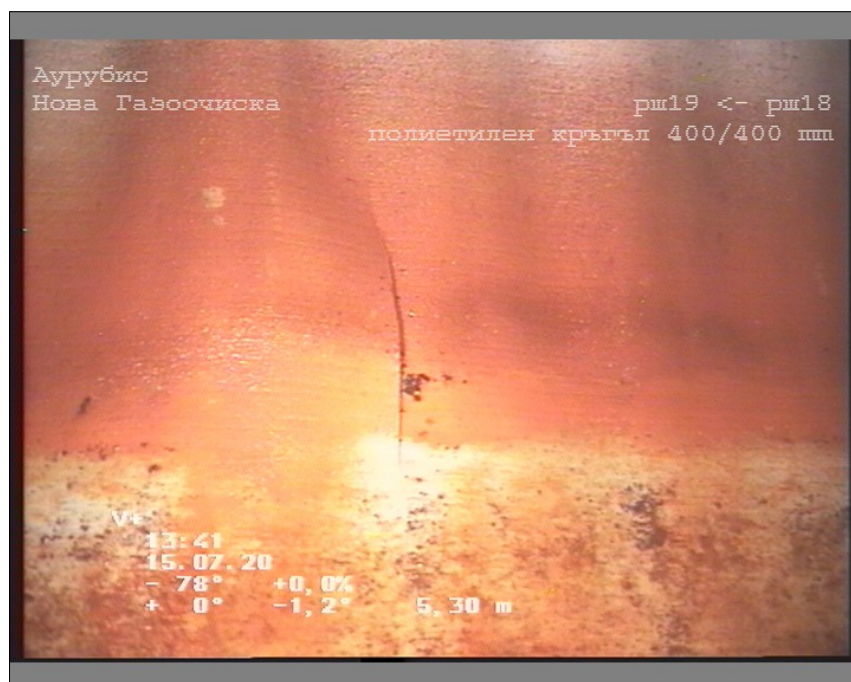
Снимка: 7_3А, Носител данни №: 15.7.2020 г._0, 00:02:01 5,3m, Пукнатини около тръбата, 1mm широк, от 8 до 9 Часа
