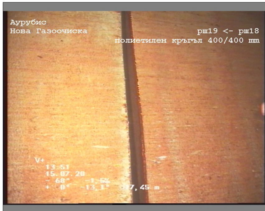
Снимка: 7_9А, Носител данни №: 15.7.2020 г._0, 00:08:07 17,45m, Множество пукнатини:отворени пукнатини по обхвата на тръбата %BreiteMM% #clock
